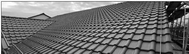
Das erst im Jahr 1996 errichtete Dach war trotz der relativ kurzen „Lebensdauer“ bereits undicht geworden und eindringendes Regenwasser führte zu Schäden an den Zwischendecken und in Teilen auch an den Fußböden.
