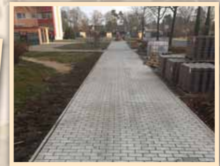
Gemeinsam mit „Wohnungswirtschaft“ und „Wohnungsgenossenschaft“ konnte der Gehweg in der Geschwister-Scholl-Straße im Wohngebiet Nord endlich saniert werden.
