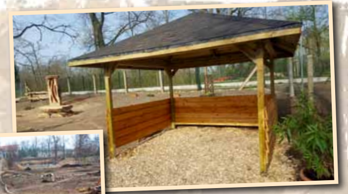
Montage und Aufstellung eines Holzpavillons im neu gestalteten Kräutergarten nebst errichteter Holzskulptur.
